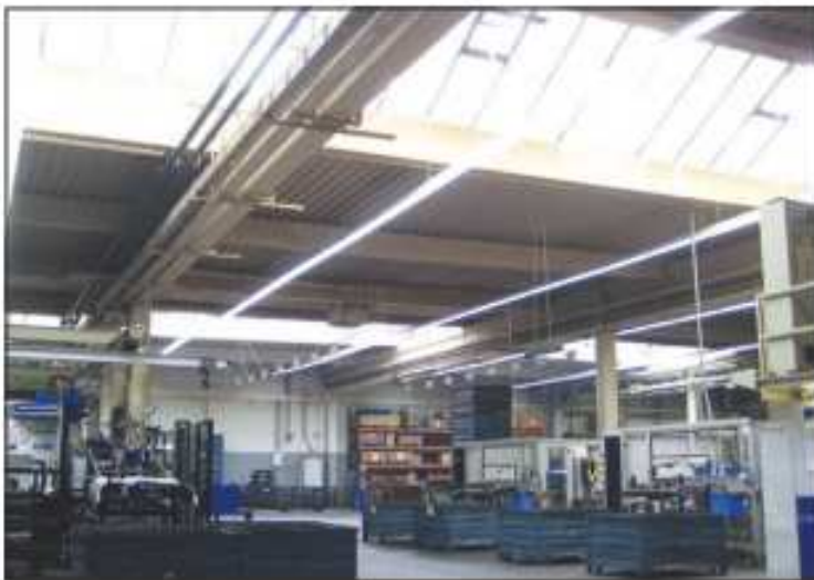
Automobilzulieferer Mubea ersetzte seine Quecksilberdampflampen durch Leuchtstoffröhren mit Spannungsabsenkung.
